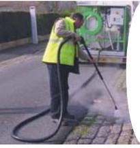
• **Principe** : Ce procédé est basé sur une forte température de l'eau (environ 138°C) à faible pression (2.5 bars). L'eau chaude est pulvérisée sous forme liquide sur la végétation à détruire. L'eau chaude appliquée directement sur la plante provoque la coagulation des protéines végétales et l'arrêt de la photosynthèse de la plante donc sa destruction. La technique n'utilise pas de carburant fossile pour chauffer l'eau, tout est électrique.
