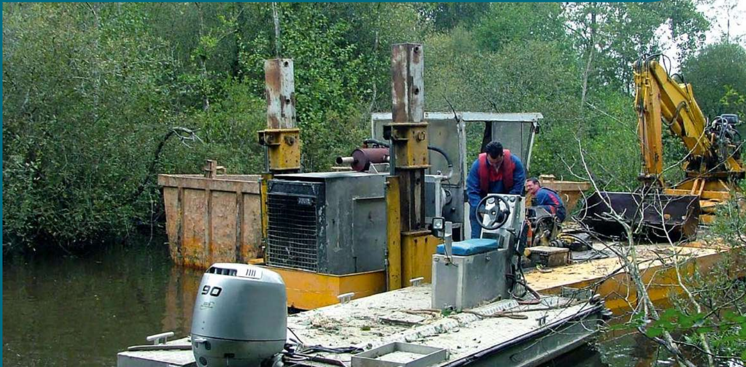
Les systèmes restaurés nécessitent moins d'entretien.
